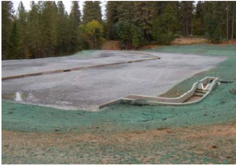
図 6.3.15 鉱山廃水のパッシブトリートメントにおける石灰岩の設置事例
