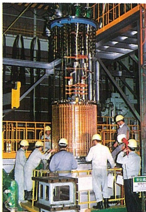
20 T級大口径超電導マグネットの地下ピット内低温容器への組み込み作業
