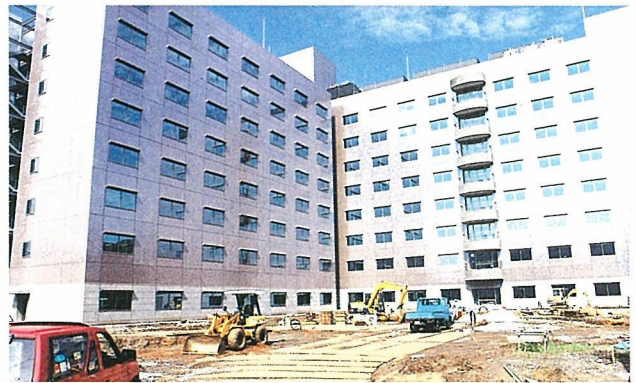
プラザ側から見た研究本館の研究ゾーン (左側：標準実験室，右側：研究居室)
